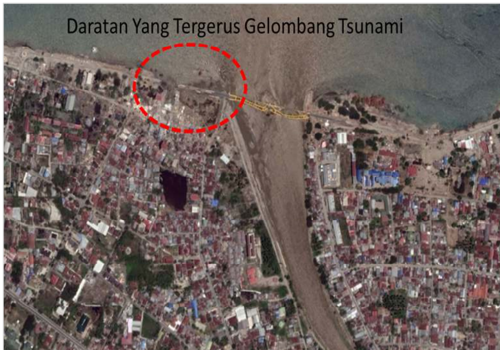
Gambar 2.10 Kerusakan Pantai Akibat Terjangan Tsunami pada Muara Sungai Palu
